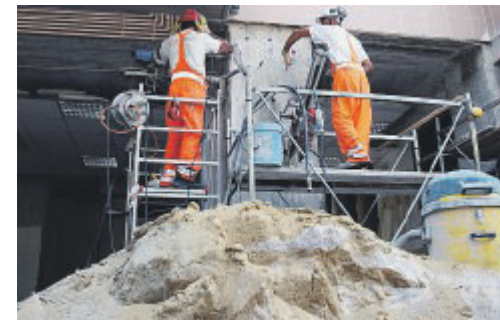
Un cantiere edile
