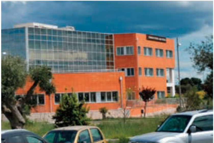
La sede dell'Area tecnica comunale
