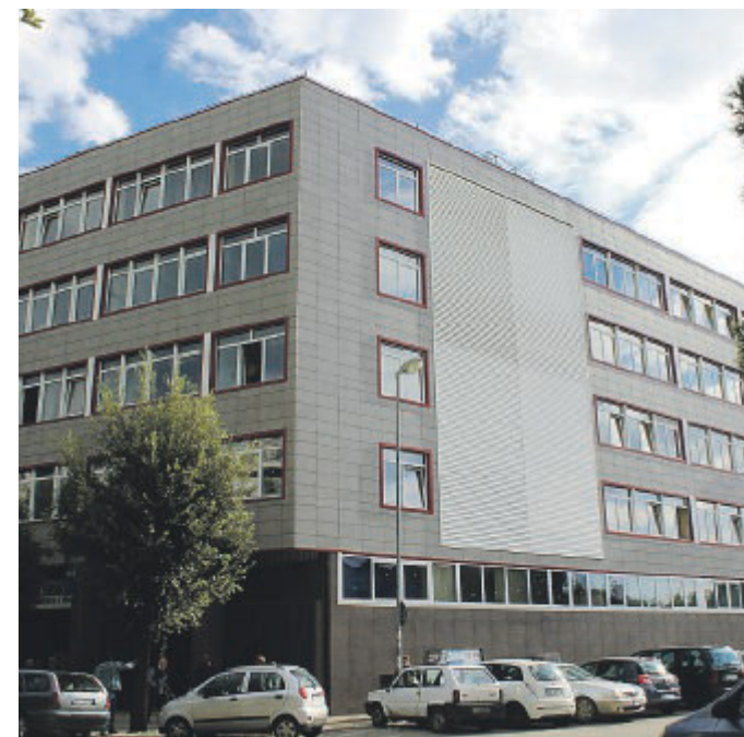
FOGGIA La sede dell'Azienda sanitaria locale di piazza della Libertà
