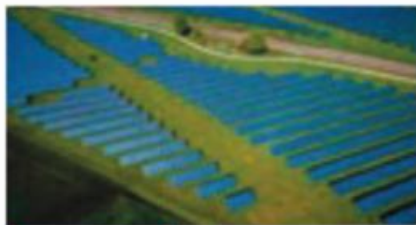
Impianto a terra
