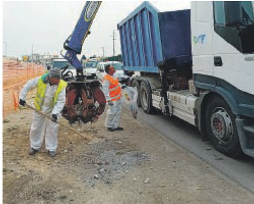
Lavori in corso lungo le provinciali
