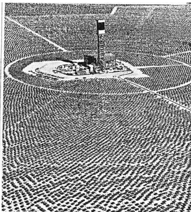
California L'Ivanpah Solar Electric Generating System è l'impianto solare termico più grande del mondo
