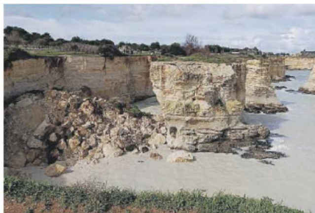
MELENDUGNO Crollo dell'Arco degli Innamorati di Torre S. Andrea
