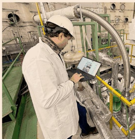
Ricerca. L'infrastruttura Circe nel centro Enea del Brasimone per studi su tecnologie dei metalli liquidi pesanti applicate ai reattori di quarta generazione raffreddati a piombo liquido
