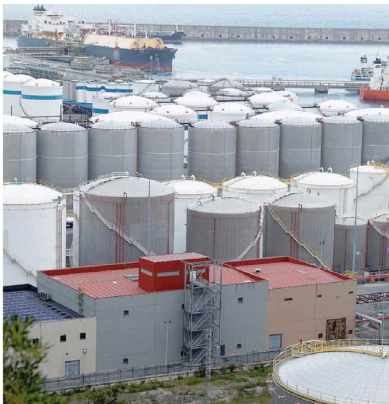
Approvvigionamento a rischio. Il terminal del porto di Bilbao con gli impianti Gnl
