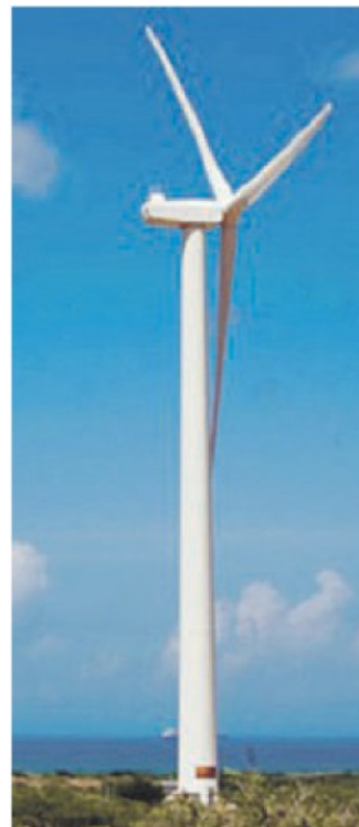
PUGLIA Impianto eolico
