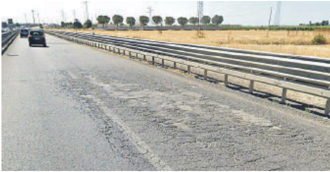
L’asfalto sbricolato in alcuni tratti della strada statale 16 bis nel tratto che da Foggia conduce a Cerignola
