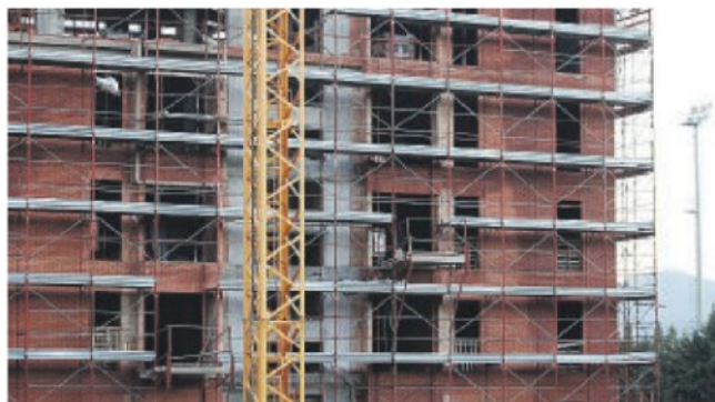
Un cantiere in provincia di Foggia
